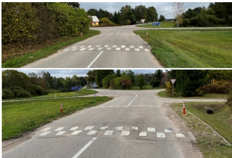
6 pav. Greičio mažinimo priemonės Pk 92+00 keturšalėje sankryžoje
